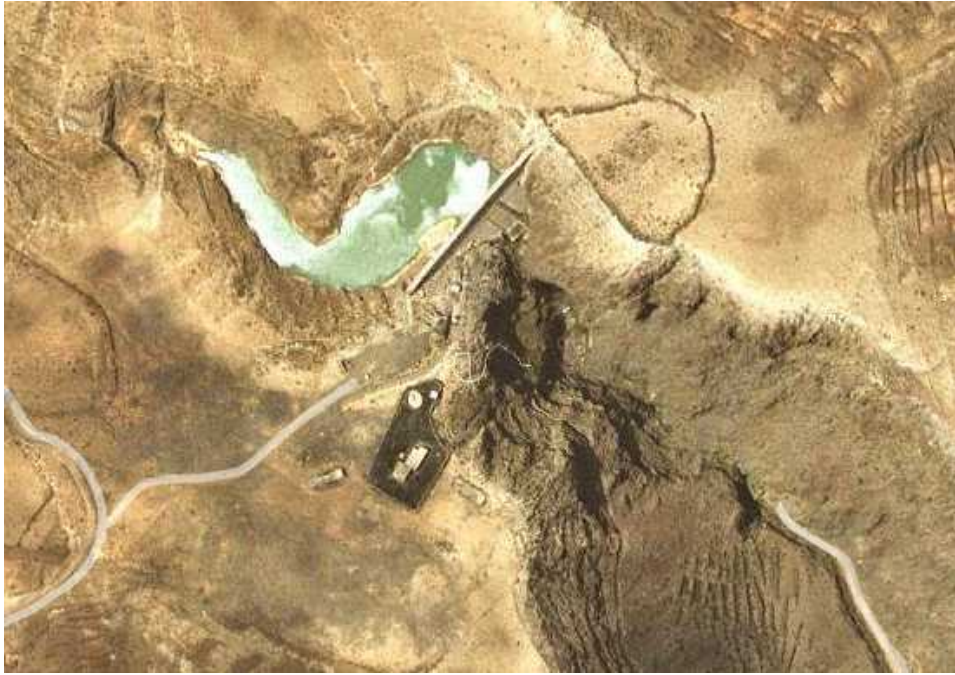
Figura 35. Vista general de la Presa de Mala.
